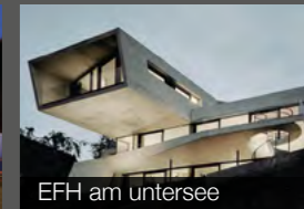
EFH am untersee
